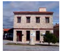
Sede de la Mancomunidad. Este edificio alberga el Museo del Agua.
